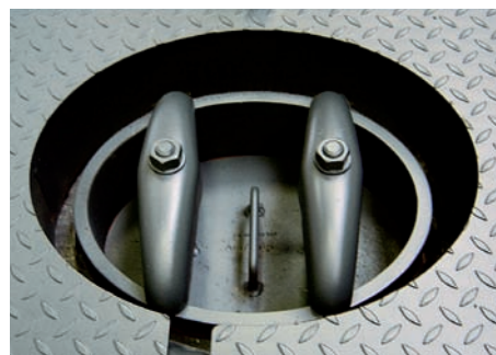
Ревизионные отверстия и лазы расположены во всех важных точках конструкции водогрейных и паровых котлов
