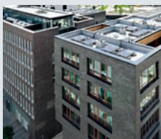
Торговый центр, Гамбург Германия
