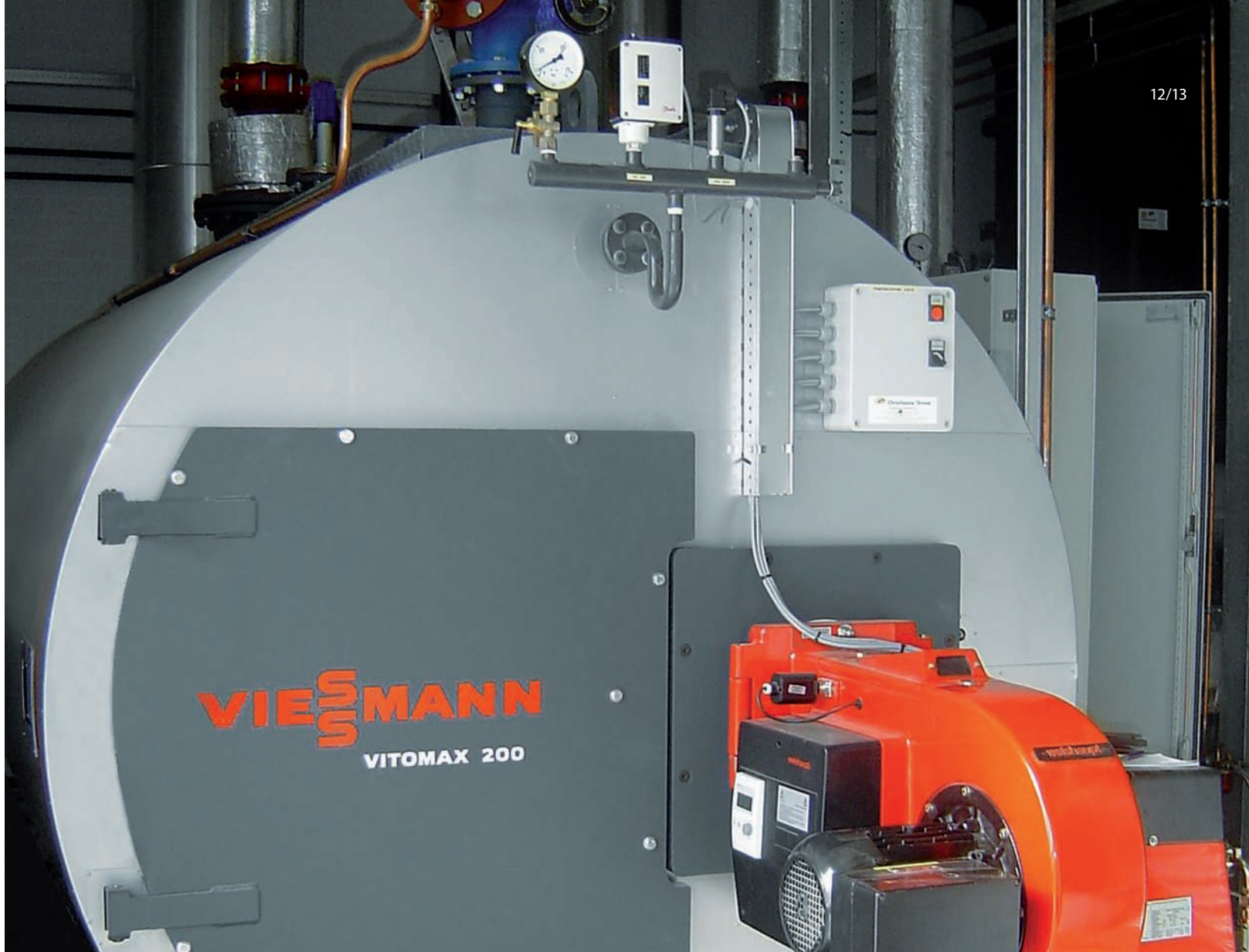
Паровой котел низкого давления Vitomax 200-LS, Тепличные грибницы, Голландия
