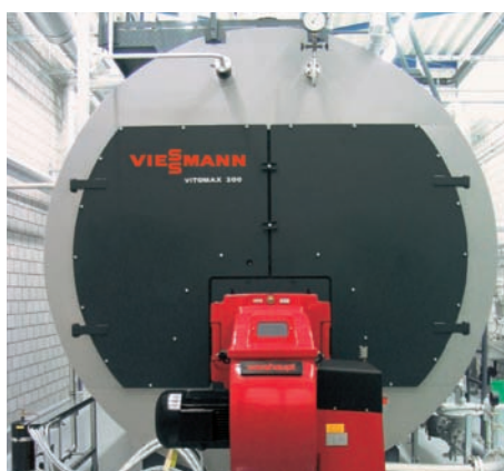
Vitomax 200-HS паропроизводительностью 10 т/ч, 13 бар Молочный завод в Люцерне, Швейцария
