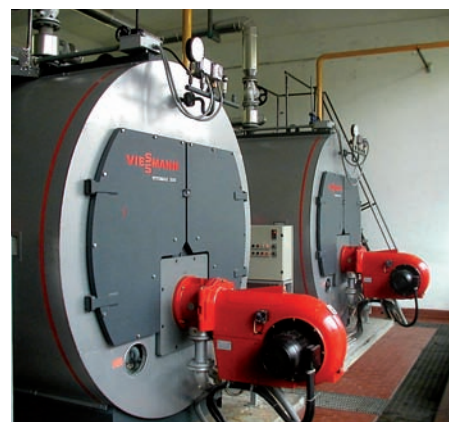
Паровые котлы установленные на трикотажной фабрике Мейланда, Италия
