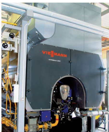
Паровой котел Vitomax 200-HS с пароперегревателем
